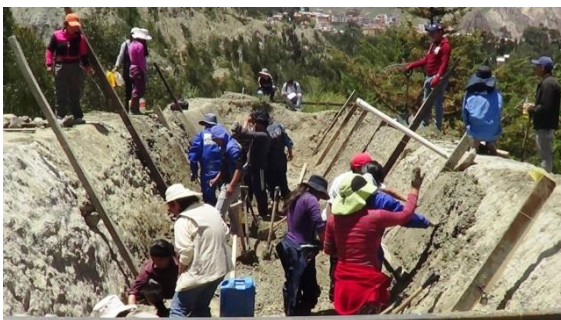
Preparado e inicio de revoque (emparejado)
