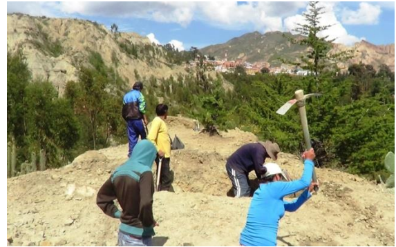
Excavación manual para el reservorio
