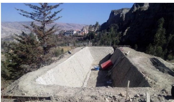
Conclusión de revoque en los taludes
