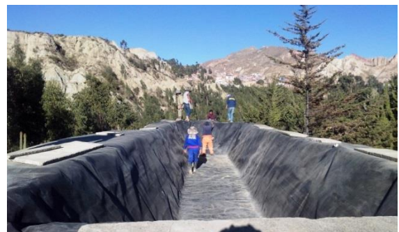
Vista reservorio revestido c/geomembrana
