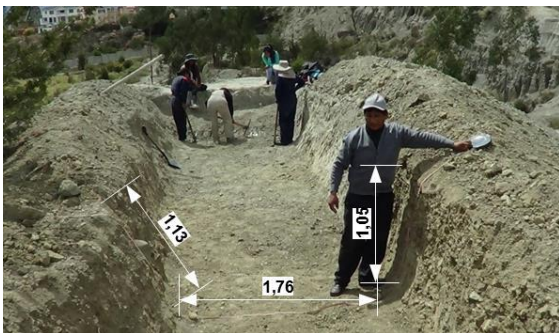
Medidas registradas durante la excavación
