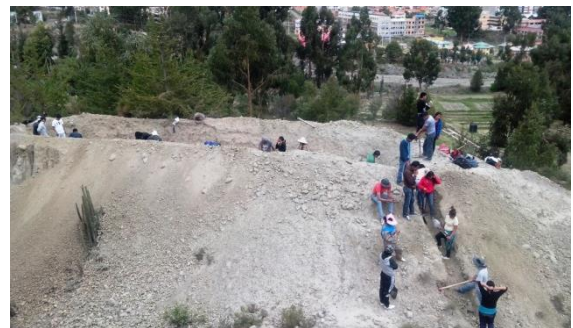
Conclusión del excavado para el reservorio
