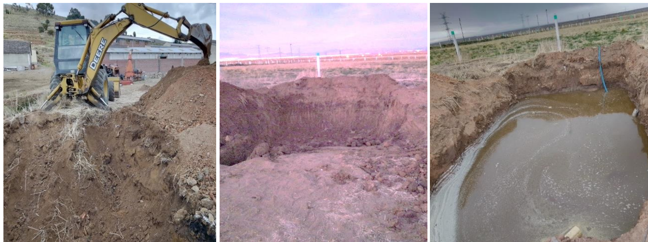
Figura 10. Excavación, compactado de tanque séptico y limpieza de lodos
