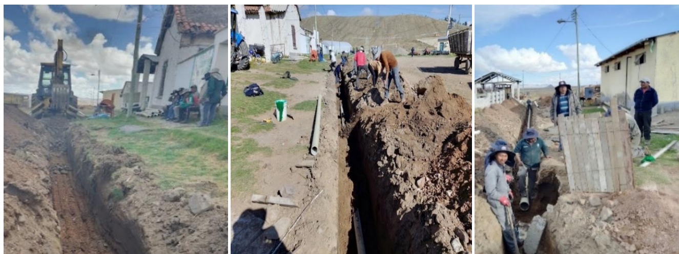
Figura 8. Excavación de alcantarillado e instalación de colectores de 4" y 6 "
